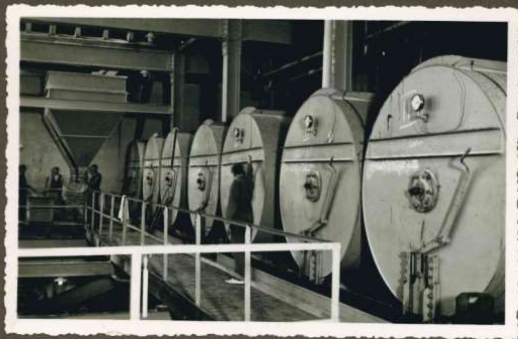
Kristalizatoros turpina cukura kristalīņu augšanas processu.
