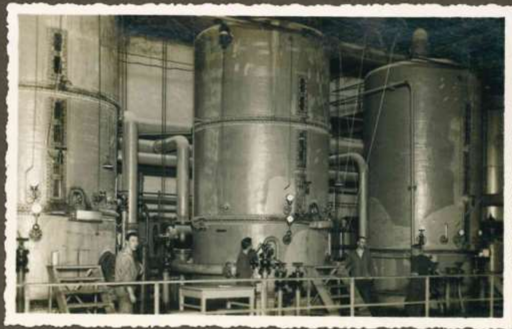
Vakuumparatos, vārot sīrupu zem pamazināta gaisa spiediena, iegūst cukura kristallmassu.
