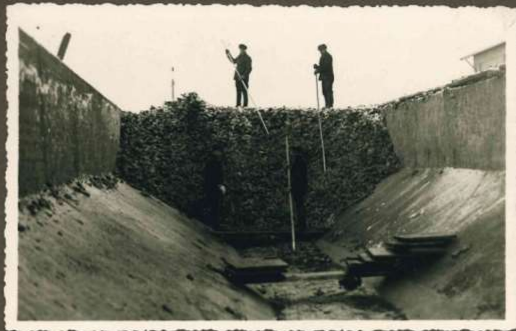
No c.biežu kanāliem bietes ar ūdens palīdzību ieplūcina fabrikā.
