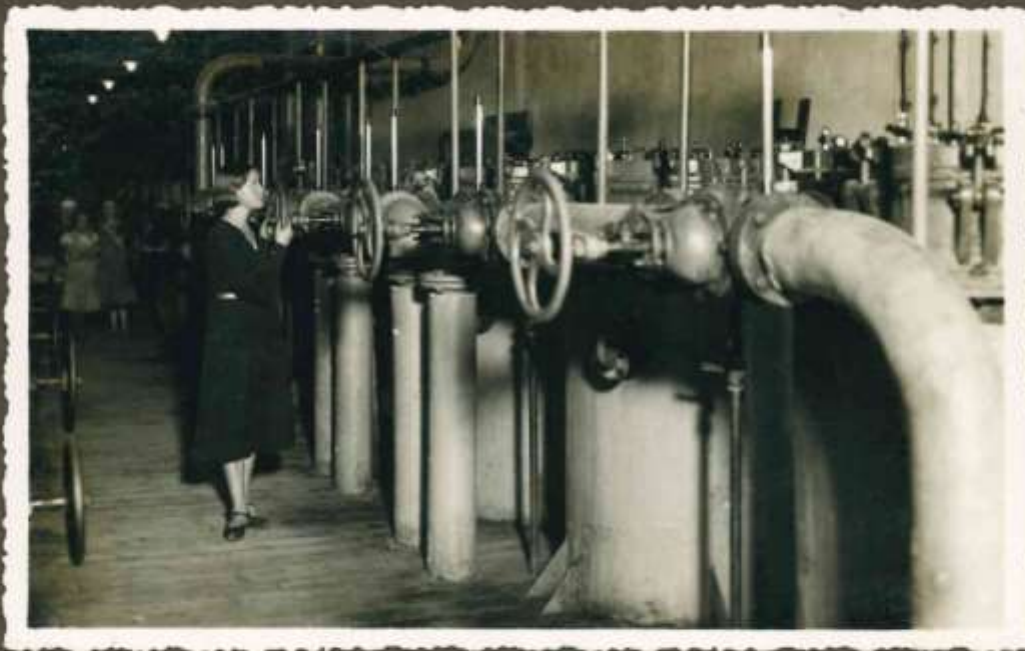
Ātrsildītājos pa fabriku cirkulējošas sulas uzsilda līdz vēlamai temperaturai.
