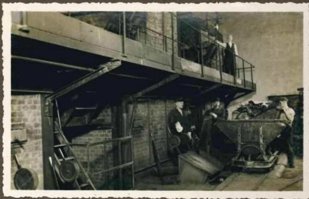
Tvaika katli ražo tvaiku spēka stacijai un cukura ražošanas procesa vajadzībām.
