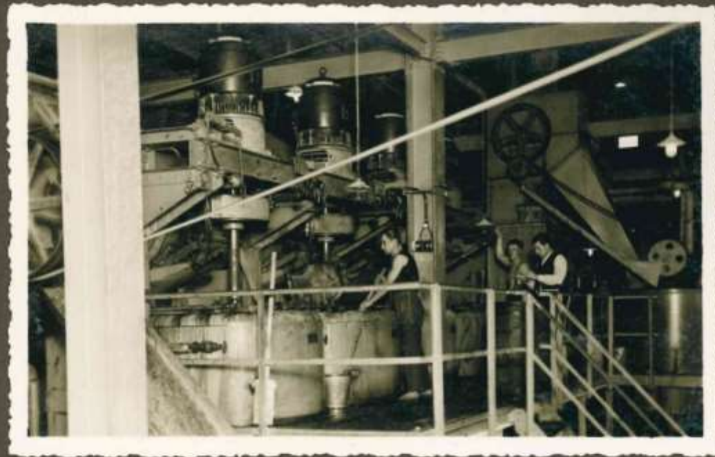
Centrifugās no kristallmassas atdala un nomazgā cukura kristaliņus.
