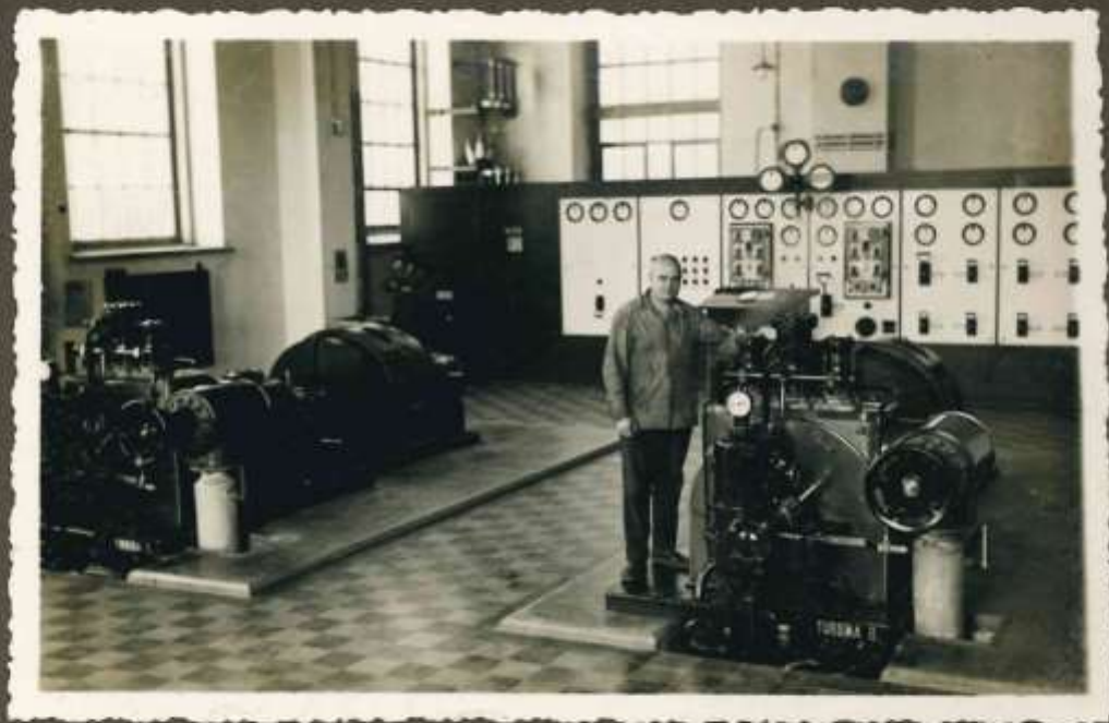
Turbogenerātori ražo elektr. enerģiju fabr. vajadzībām.
